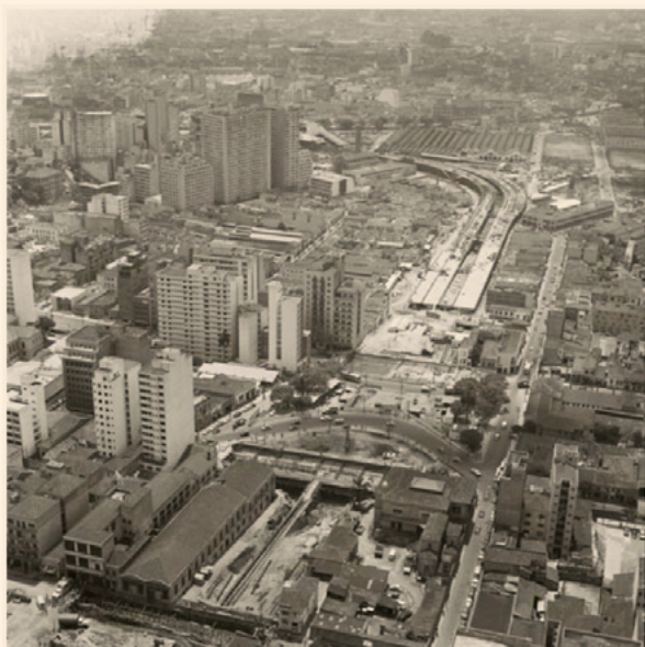
Figura 12 Avenida Radial Leste-Oeste
