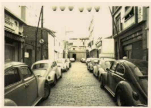
Figura 5 Beco dos Aflitos, 1976
