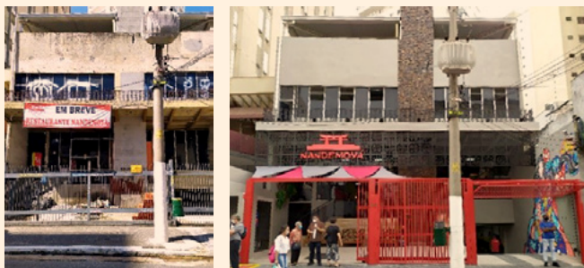
Figura 18 Renovação da fachada de edificação na rua Galvão Bueno
