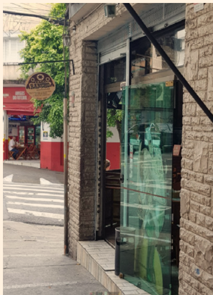
Figura 1 Fachada do restaurante Rancho Nordestino
