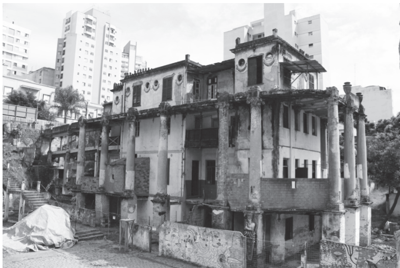
Figura 3: Casarão principal que integra a Vila Itororó, durante as obras de restauração
