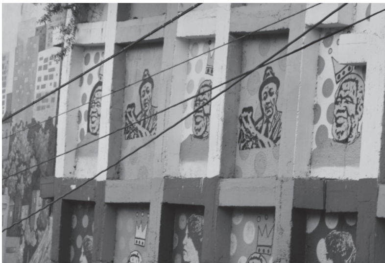
Figura 6: Painel muro de arrimo da rua Almirante Marques Leão
